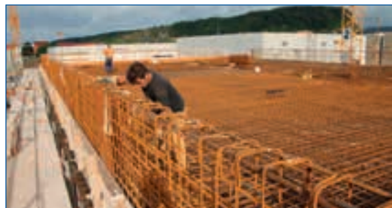
Oktober 2011 / Das Dach entsteht
