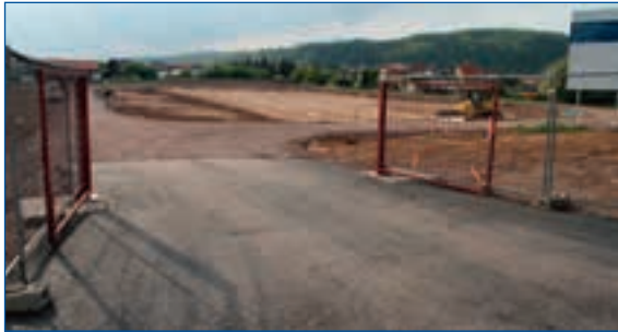
Februar 2011 / Erschließung des Baufeldes
