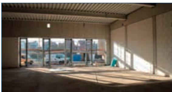
November 2011 / Die Werkstätten entstehen
