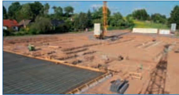
Mai 2011 / Beginn Armierungsarbeiten Bodenplatte
