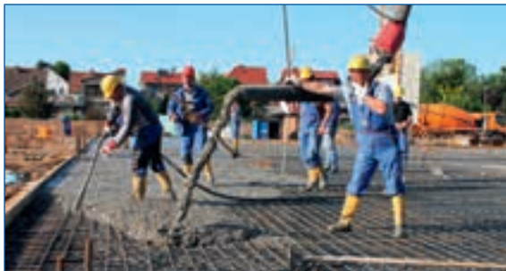
Mai / Juni 2011 Betonierung der Bodenplatten
