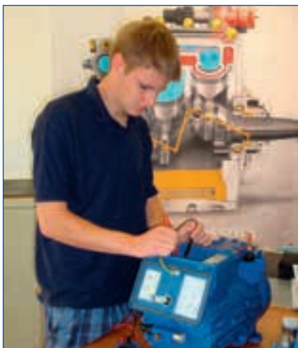
Reparatur an einem Kompressor
